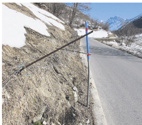
Im Herbst stehen gelassene Zäune können Strassenbenutzer gefährden, wenn sie von der Schneelast in den Fahrbereich gedrückt werden.
